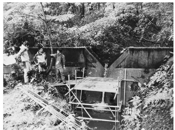
写真 1 量水堰堤 W1 と下流側に取り付けた作業用足場。
