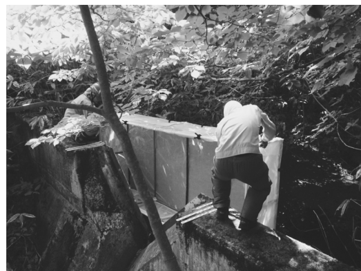
写真 3 スクリーンを堰堤に取り付けている様子.
