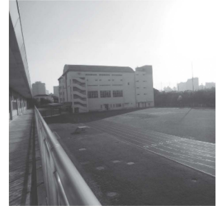
写真6 南北校舎から見た東校舎
