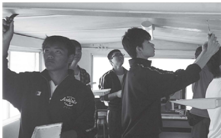
Fig.3. 倉庫の改修作業を行う生徒たち
