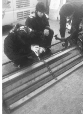
<写真8: ベンチ補修>
