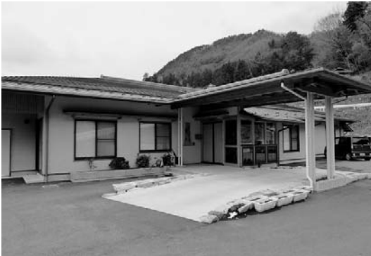
写真-2 『悠々』の正面玄関
