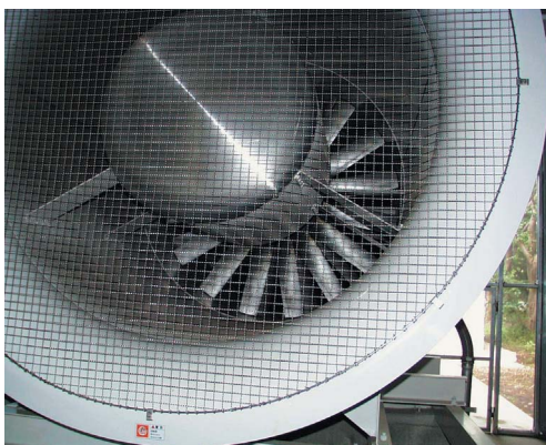
図 2 吸込みベルマウスと軸流送風機
