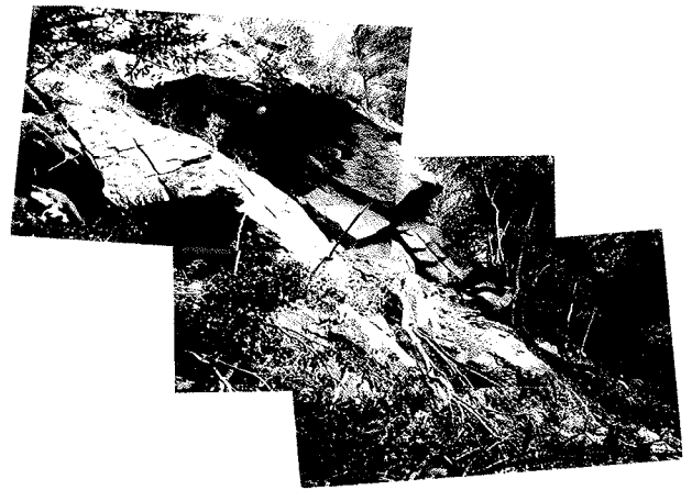
写真-4 日野郡小河内の落石発生場所
