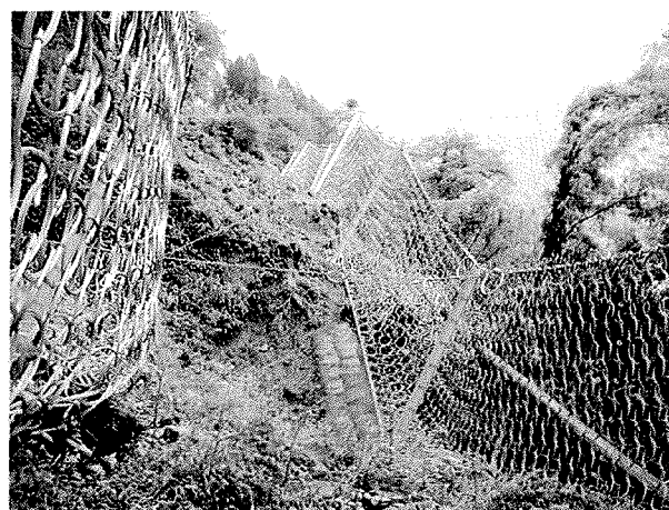
写真-8 復旧状況写真
