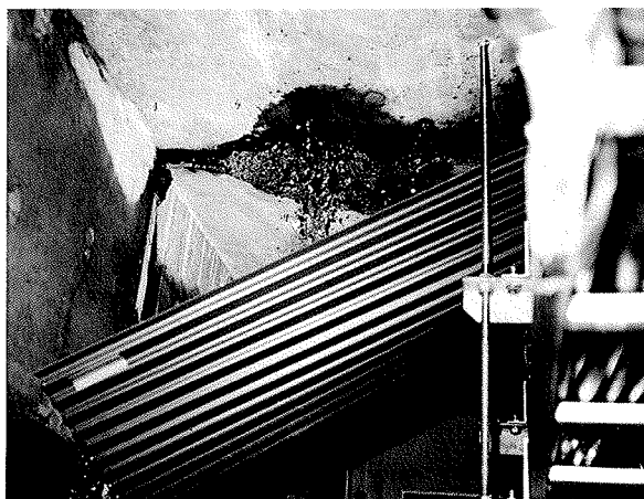
写真-5 管廊クラック被害
