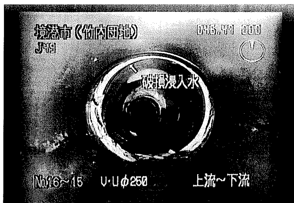
写真3 本管の破損・浸入水
