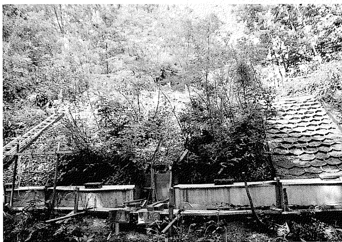
写真1 調査のり面の様子
