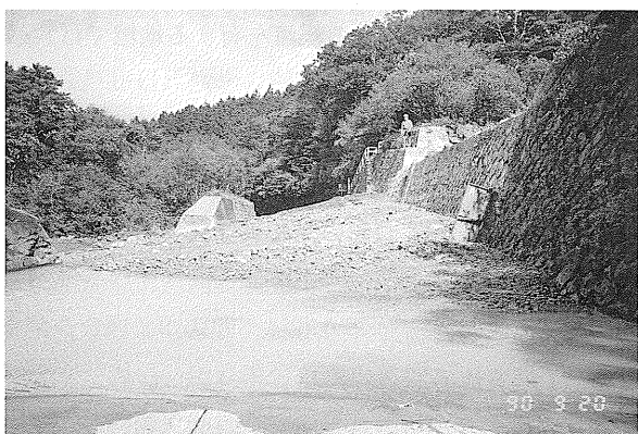
写真4 90年9月19日出水による県道への土砂流出
