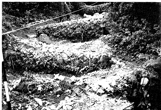
写真2 蛇かごによる侵食対策工
