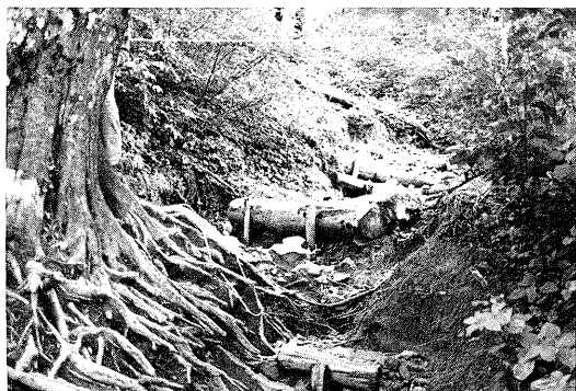
写真1 地上根より深掘れした登山道
