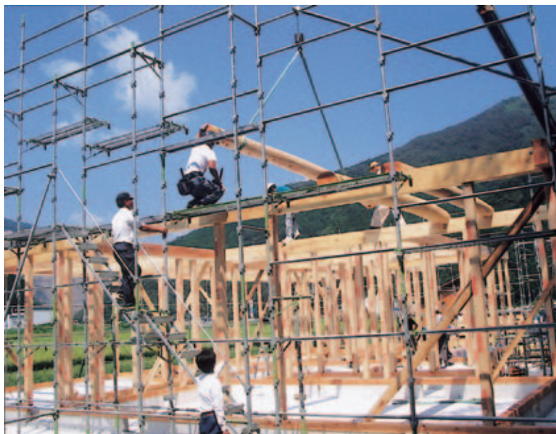
建設中の伝承館
