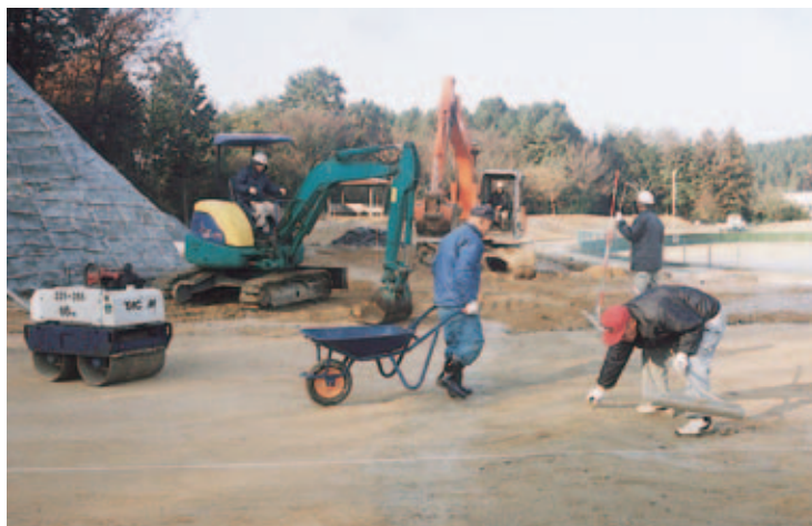
建設中の奈義町グラウンドゴルフ場
