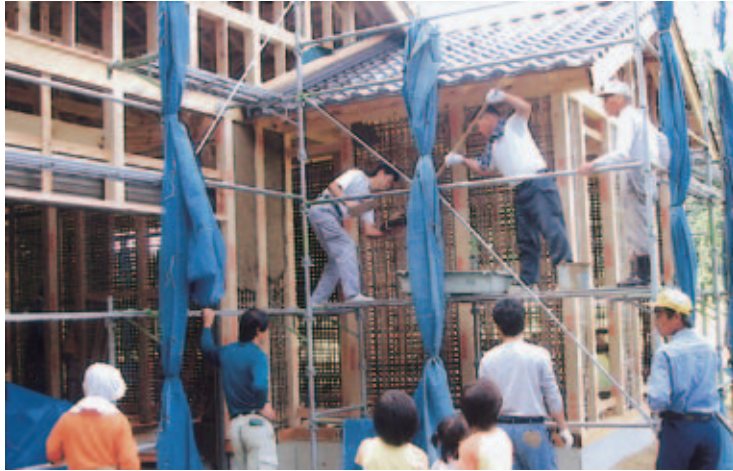
建設中の伝承館
