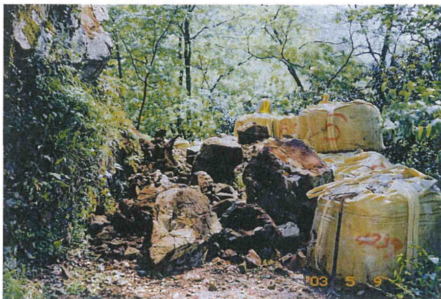
写真 2.3.8 写真 2.3.7 の崩壊した岩塊
