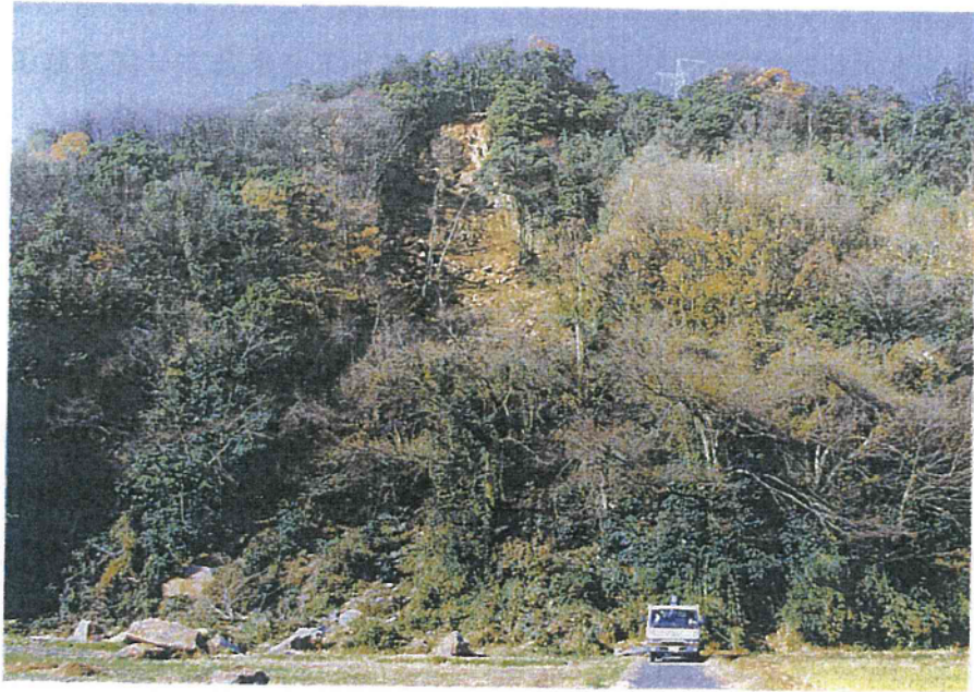
写真 2.7.2 崩壊地全景 (A地区)
