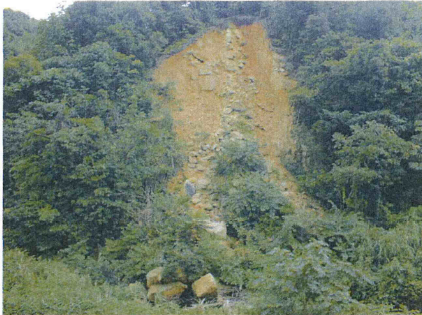
写真 2.3.14 風化花崗岩の斜面崩壊（鳥取県西伯町）
