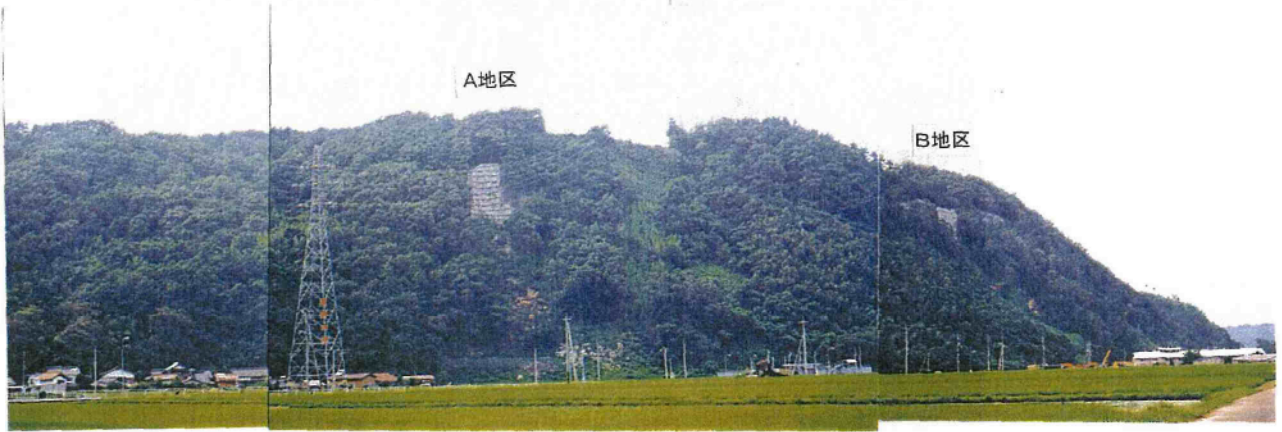
写真 2.7.1 崩壊地の遠景（A，B地区を約 500m南東から見る） 丘陵台地が広がり，その周縁が急傾斜地となっている。
