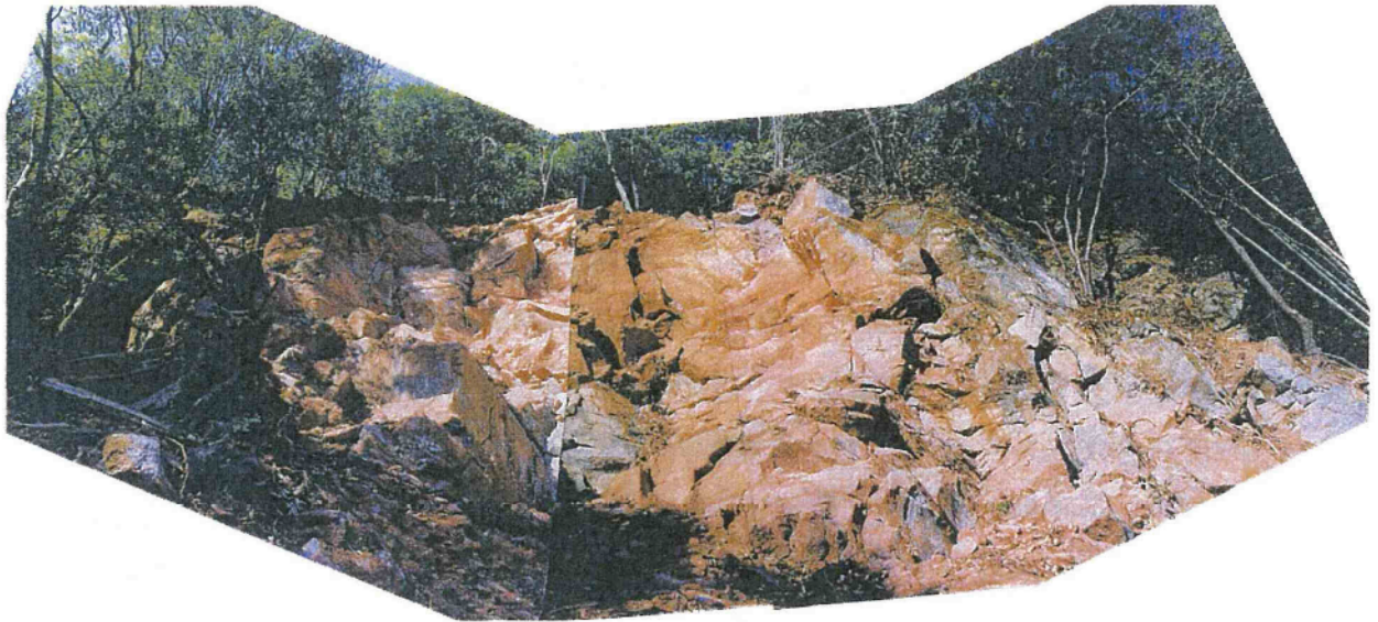
写真 2.7.4 崩壊面の状況
