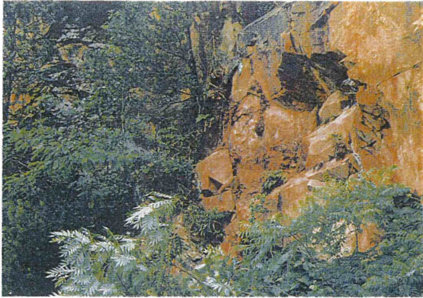
写真 2.3.9 岩塊のはく離跡（花崗岩）（鳥取市）
