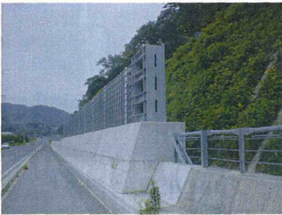
写真 3.4.6 高エネルギー吸収型落石防護柵 (鳥取県溝口町)
