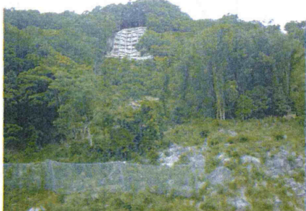
写真 3.4.1 のり枠アンカーとリングネット (鳥取県溝口町)
