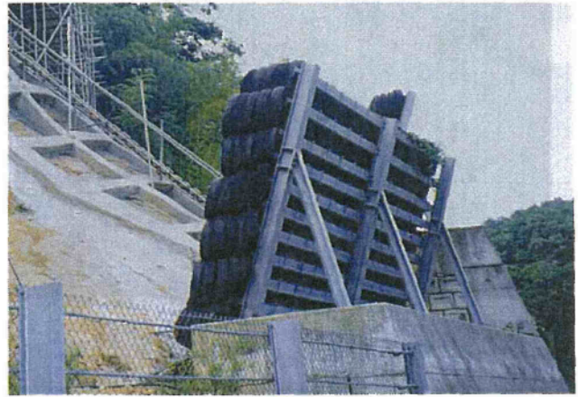
写真 3.4.7 古タイヤを使った防護柵 (鳥取市)
