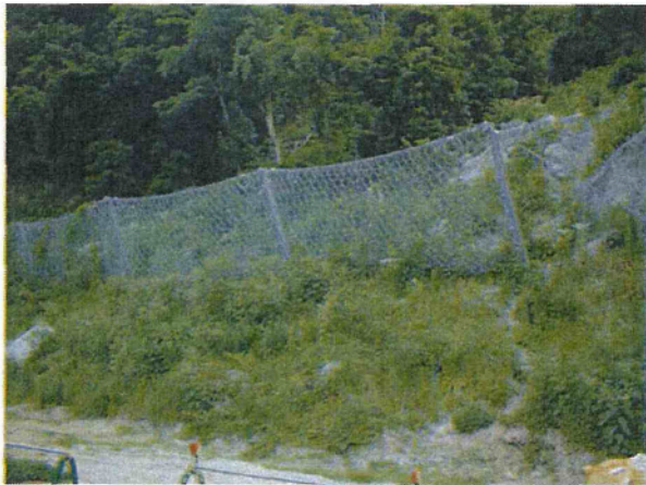
写真 3.4.10 リングネット (鳥取県溝口町)
