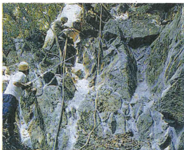
写真 3.4.3 接着ボンド工法 (兵庫県佐用町)
