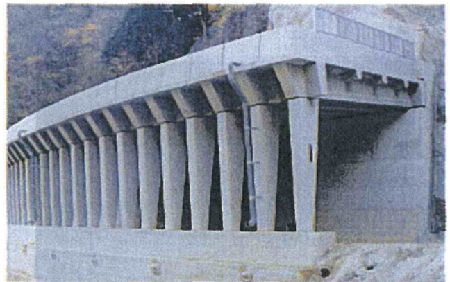
写真 3.4.11 ロックシェッド
