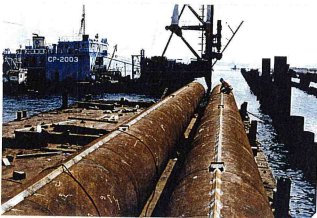
写真-3.1 鋼管杭への試験片の取付状況
