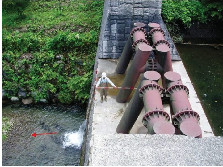
写真-3.1.2 福原2号砂防堰堤を左岸側から望む（国土交通省提供）
