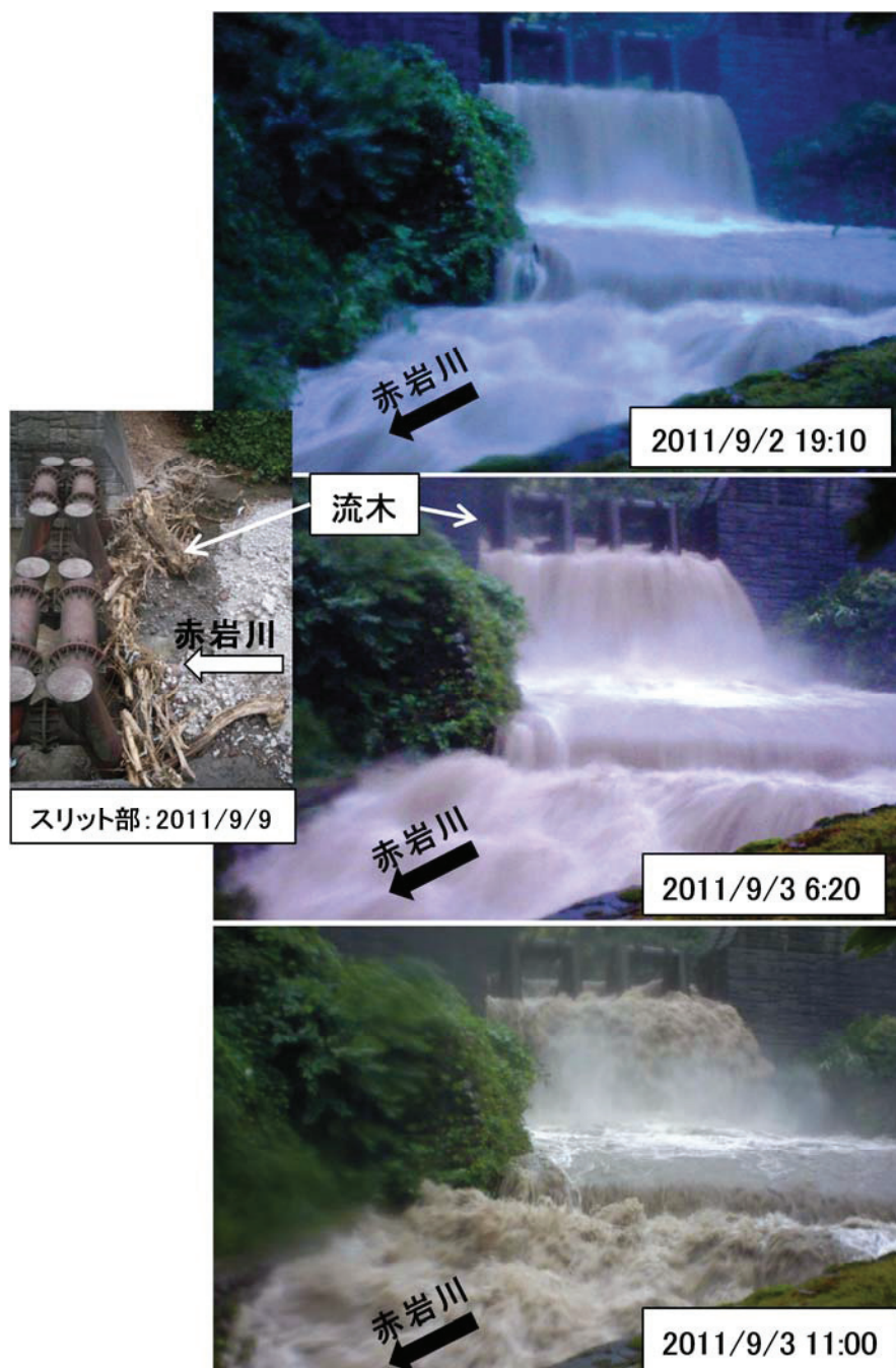
図-3.2.2 福原2号砂防堰堤の流況画像
