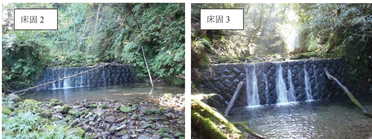
写真-3.1.3 福原2号砂防堰堤上流の床固群の状況
