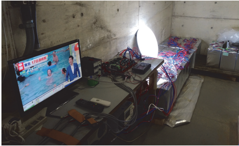
図 3.32 1 kWh 級電源システムの実験状況
