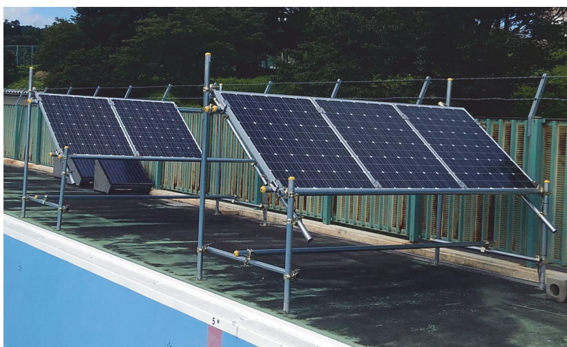
図 3.31 PV モジュールの設置状況
