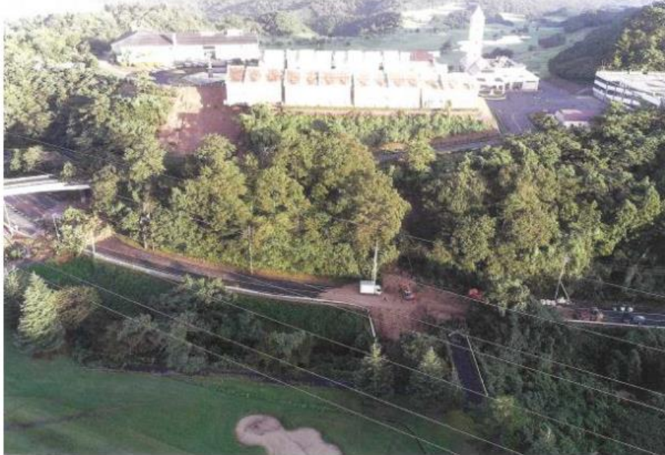
図 2-6 鳥取県内における道路の被災事例 崩壊土砂の状況 8)
