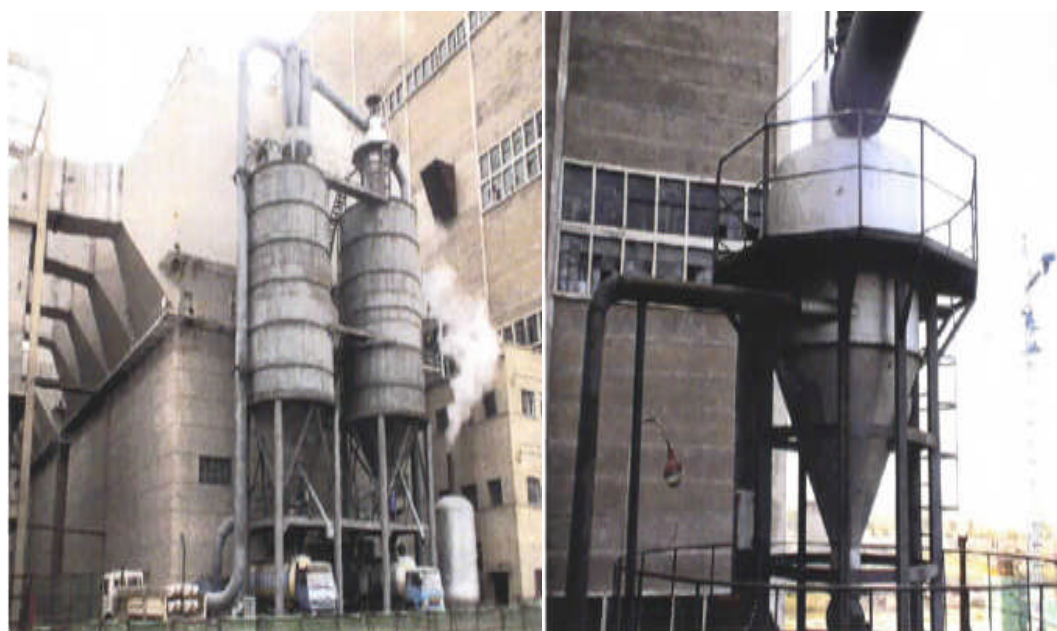
Fig.2-2 通遼市石炭火力発電所におけるフライアッシュ分級システム 28) Grade system for fly ash in the charcoal thermal power station in Tongliao
