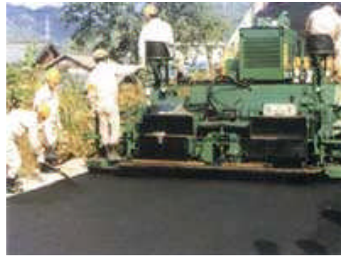
Fig.1-6 アスファルト舗装施工 Asphalt pavement construction
