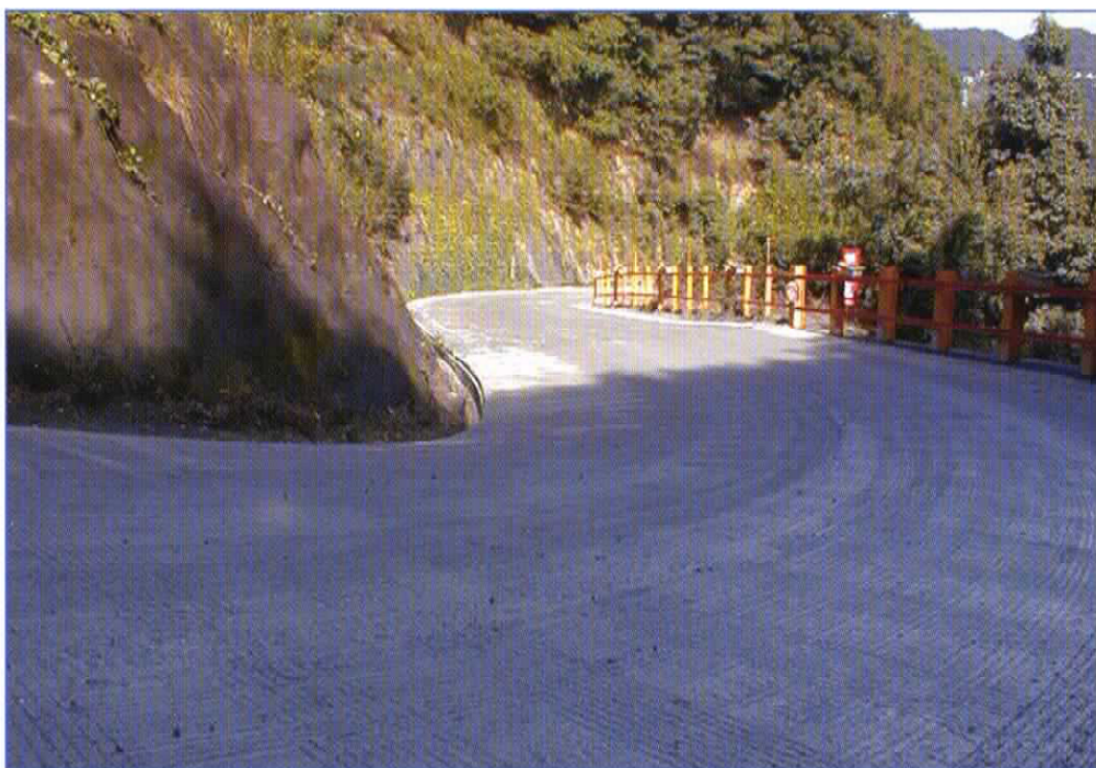
Fig.5-1 ポリプロピレン繊維を混入した道路舗装 Concrete pavement with polypropylene fibers
