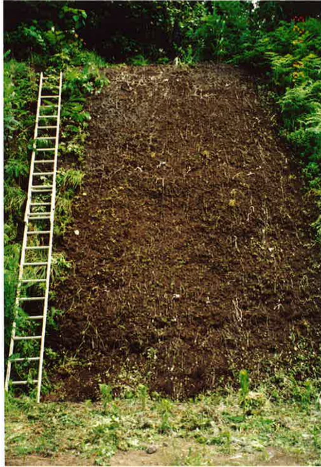
Photo. 4-1 急傾斜切土法面（裸地フィールド）試験状況
