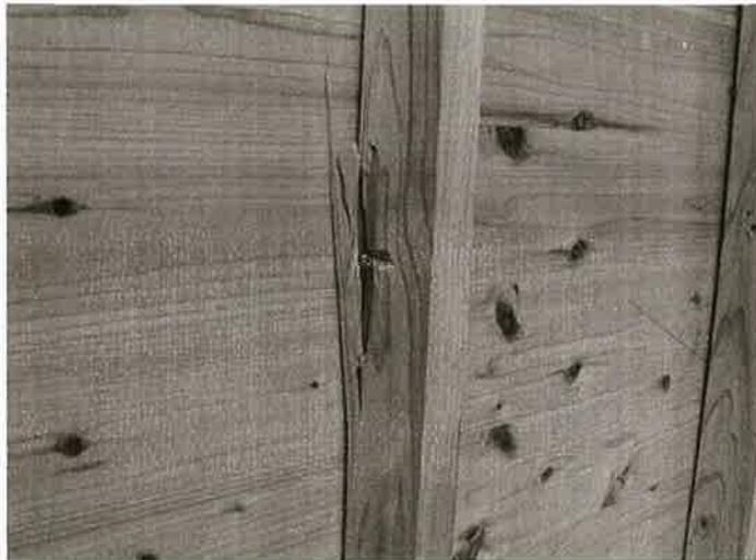
第5-3-8図 裏面ビスによる栈木の割裂
