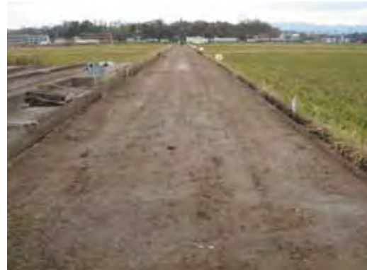
(b) 区間7から区間1に向かって撮影
