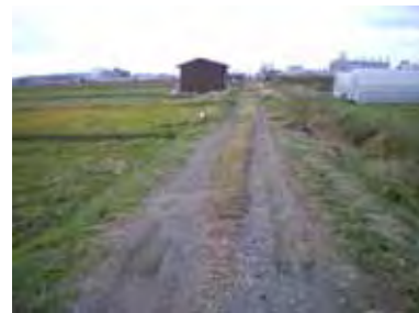
路面 IV (一般ほ場内農道, L=118m)
