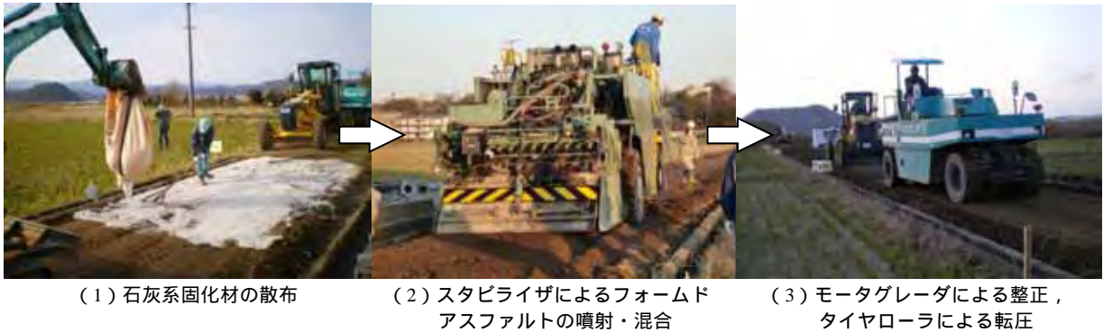
写真-6.2 試験舗装の施工状況
