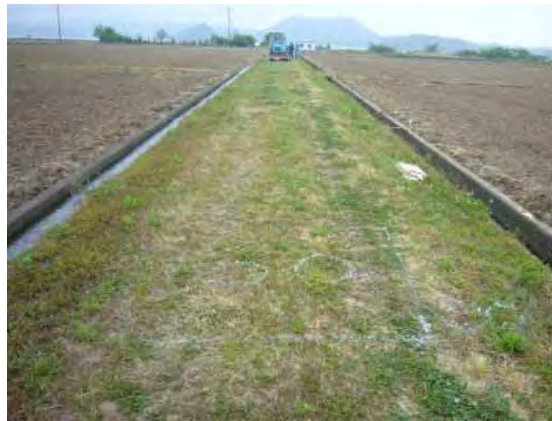
写真-6.1 既設舗装の状態
