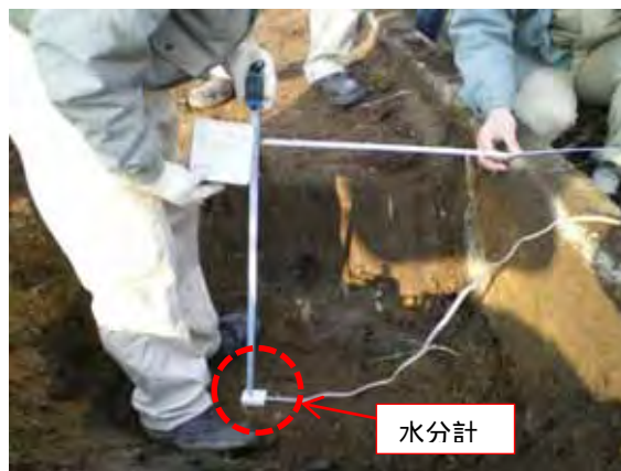
写真-6.7 水分計設置状況
