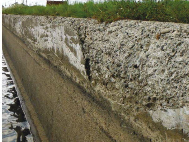
写真 2-4 表面のひび割れの状況
