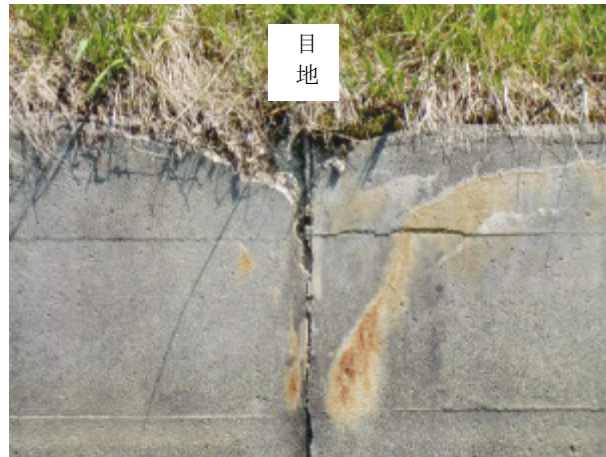
写真 2-1 目地から斜めに立ち上がるひび割れ
