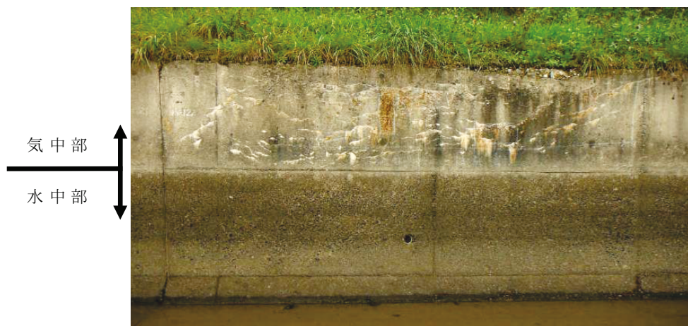
写真 2-2 表面のひび割れの状況
