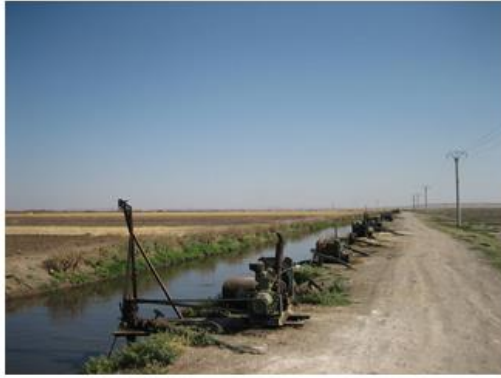
写真 1 灌漑水源であるクウェイック川沿いに並ぶ取水用のポンプの様子.
