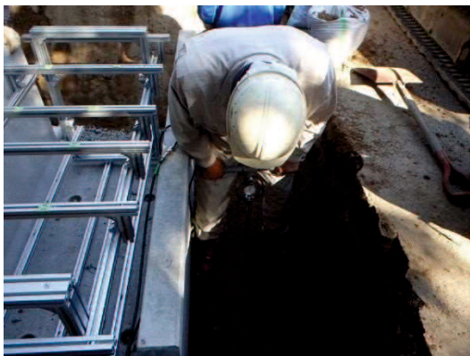
写真 5.17 ホータブルコン貫入試験状況
