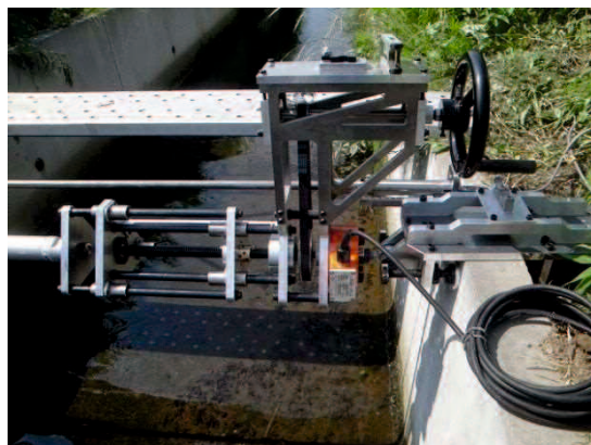
写真 5.4 水路壁載荷装置の設置状況
