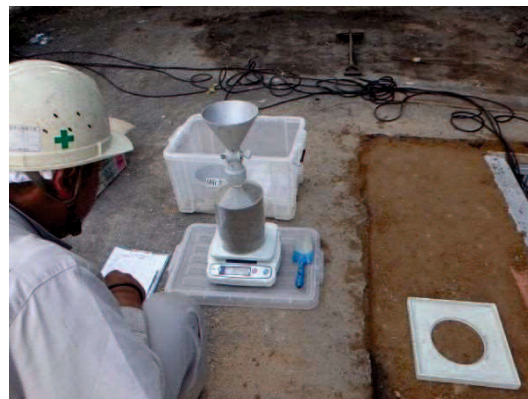
写真 5.18 砂置換法土密度試験状況
