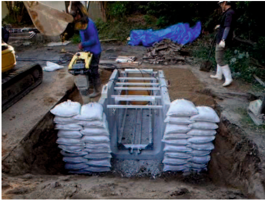
写真 5.15 埋戻し土転圧状況
