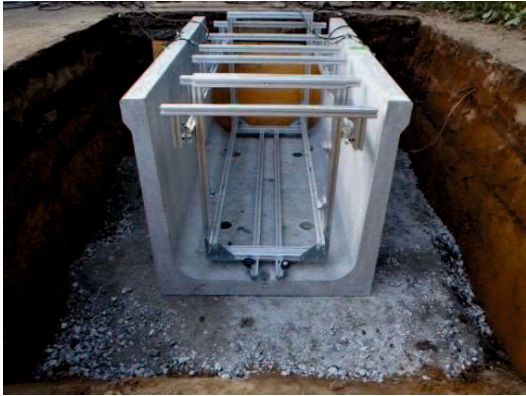
写真 5.13 試験体設置状況
