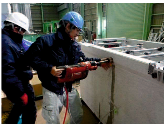
写真 4.5 小径コアによる削孔状況
