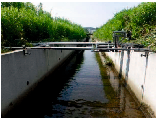
写真 5.3 水路壁載荷装置の設置状況
