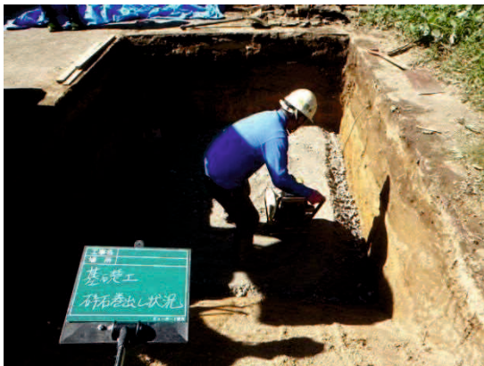
写真 5.11 砕石巻き出し状況
