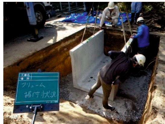
写真 5.12 試験体設置状況
