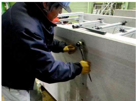
写真 4.7 ボルト締結状況
