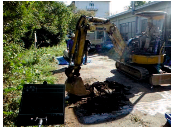
写真 5.8 舗装取り壊し状況
