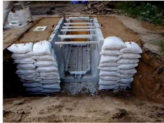
写真 5.16 施工完了状況
