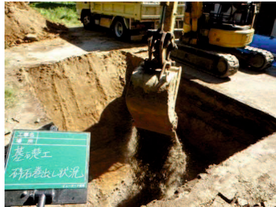
写真 5.10 砕石巻き出し状況
