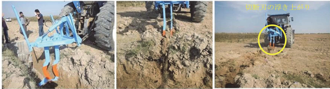
仮排水路に穿孔機をセット
