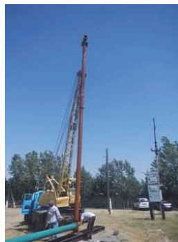
メンテナンス中の垂直排水（写真右は水中ポンプ） ミルザバット地区オコルティン WCA 内 (2016/6/7)
