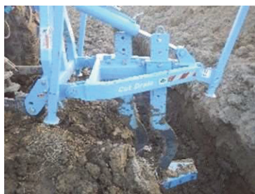
カットドレーンの施工(圃場内の仮排水路に直接接続) (2014年12月21日)
