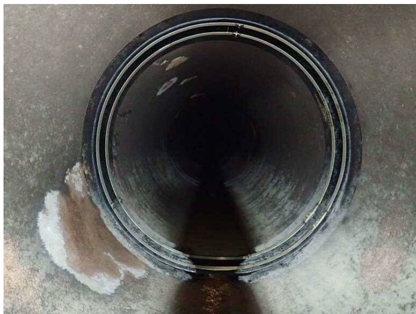
Fig.4-13 止水バンドの設置状況（第 2 号調圧水槽下流地点）
