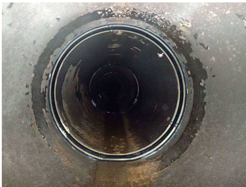
Fig.4-10 止水バンドの設置状況（第 1 号調圧水槽下流地点）
