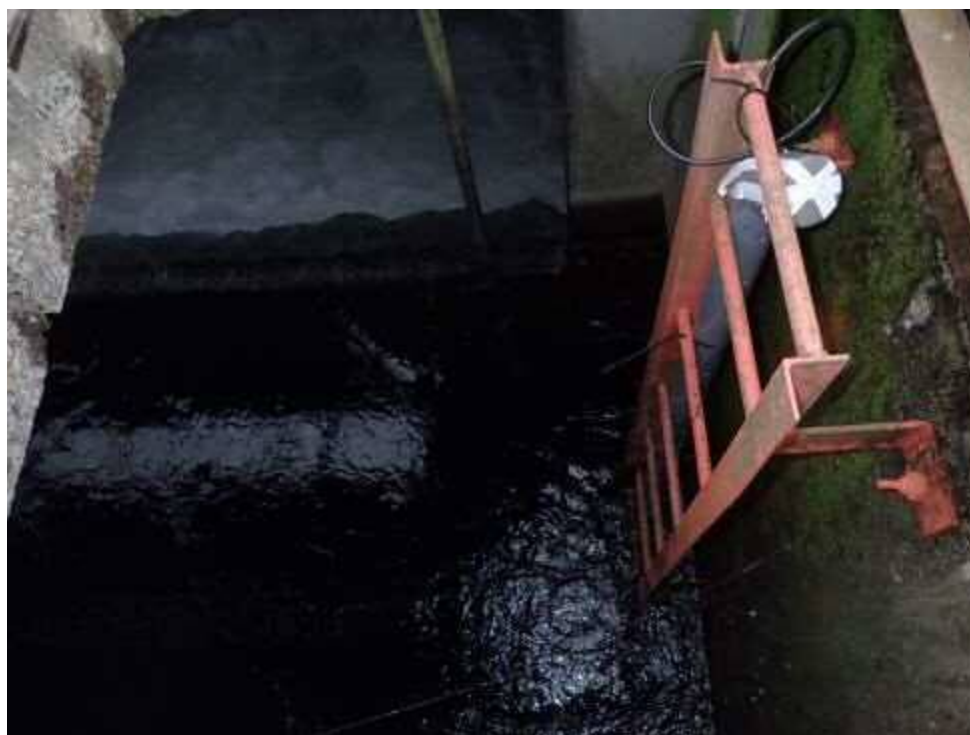
Fig.4-7 水位計の設置状況（第2調圧水槽）
