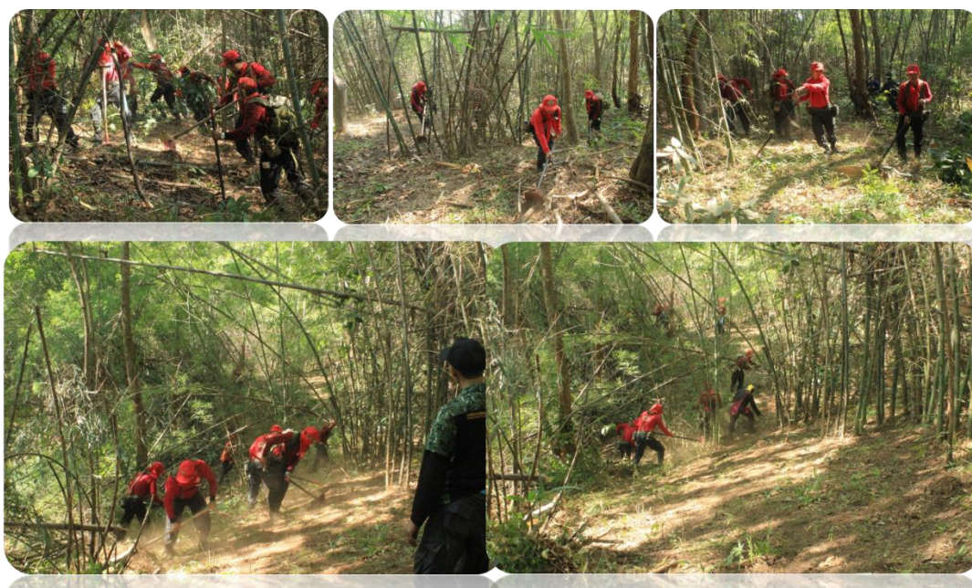
(d) Fire break construction 3-5 meter width surround sample plots
