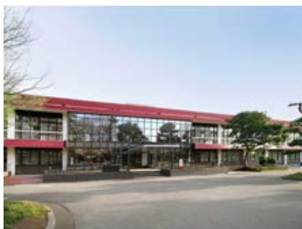
耐震改修工事後の中央図書館（2010）
