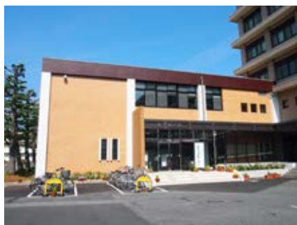
耐震改修工事後の医学図書館（2013）
