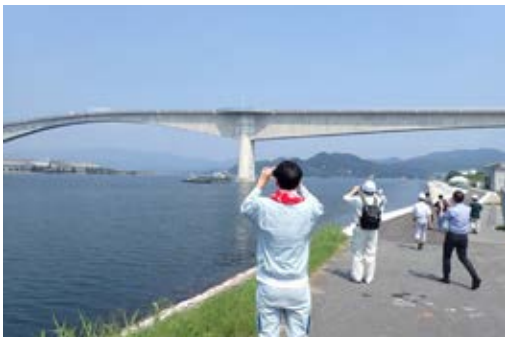
2018年7月江島大橋での新技術実装試験
