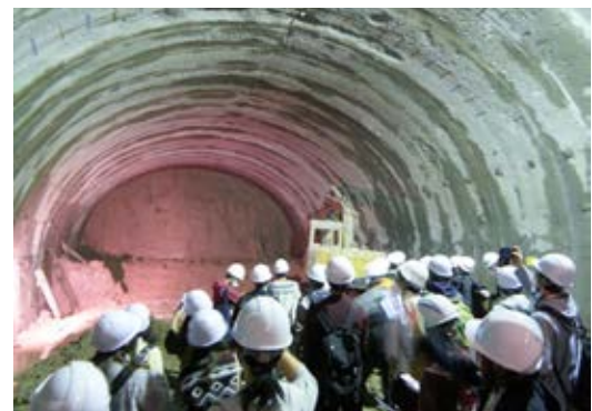
トンネル切羽を見学する学部生
