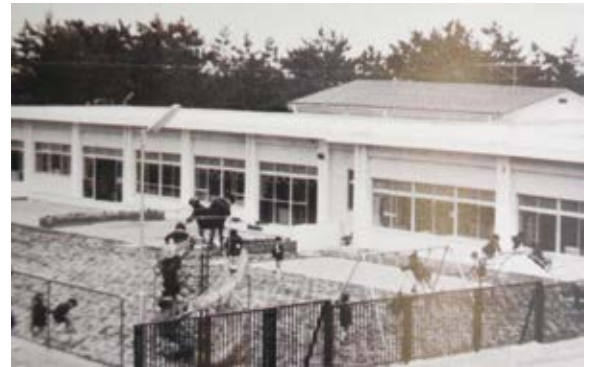
附属幼稚園園舎
