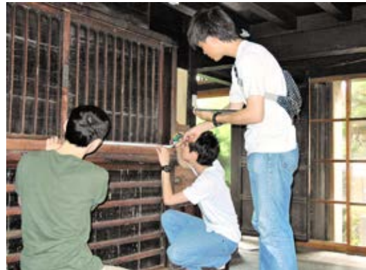
古建築の実測調査の様子
