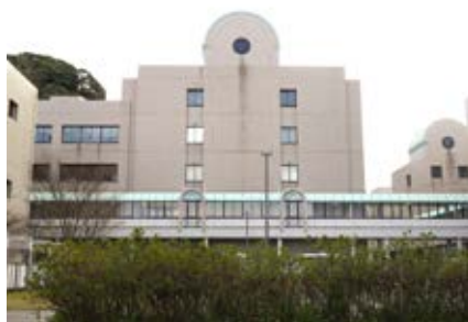
研究支援棟A (米子地区動物実験施設・放射線施設)
