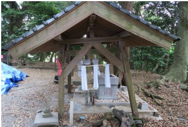
写真-1 手水舎の跳躍後の全景 (北から南向きに撮影)
