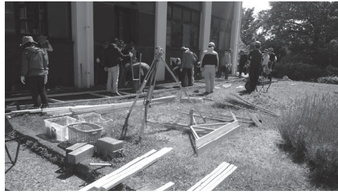
写真-23 農学部1号館北西側の小道整備。基礎工事中（2016年6月）
