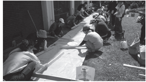
写真-24 農学部1号館北西側の小道整備。表層舗装材の敷き均し（2016年6月）
