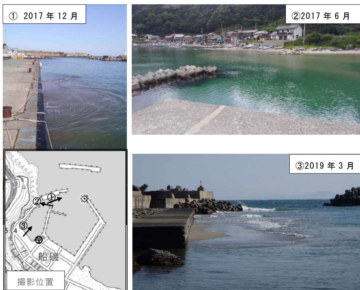
図 2.8 船磯漁港 港内堆砂状況
