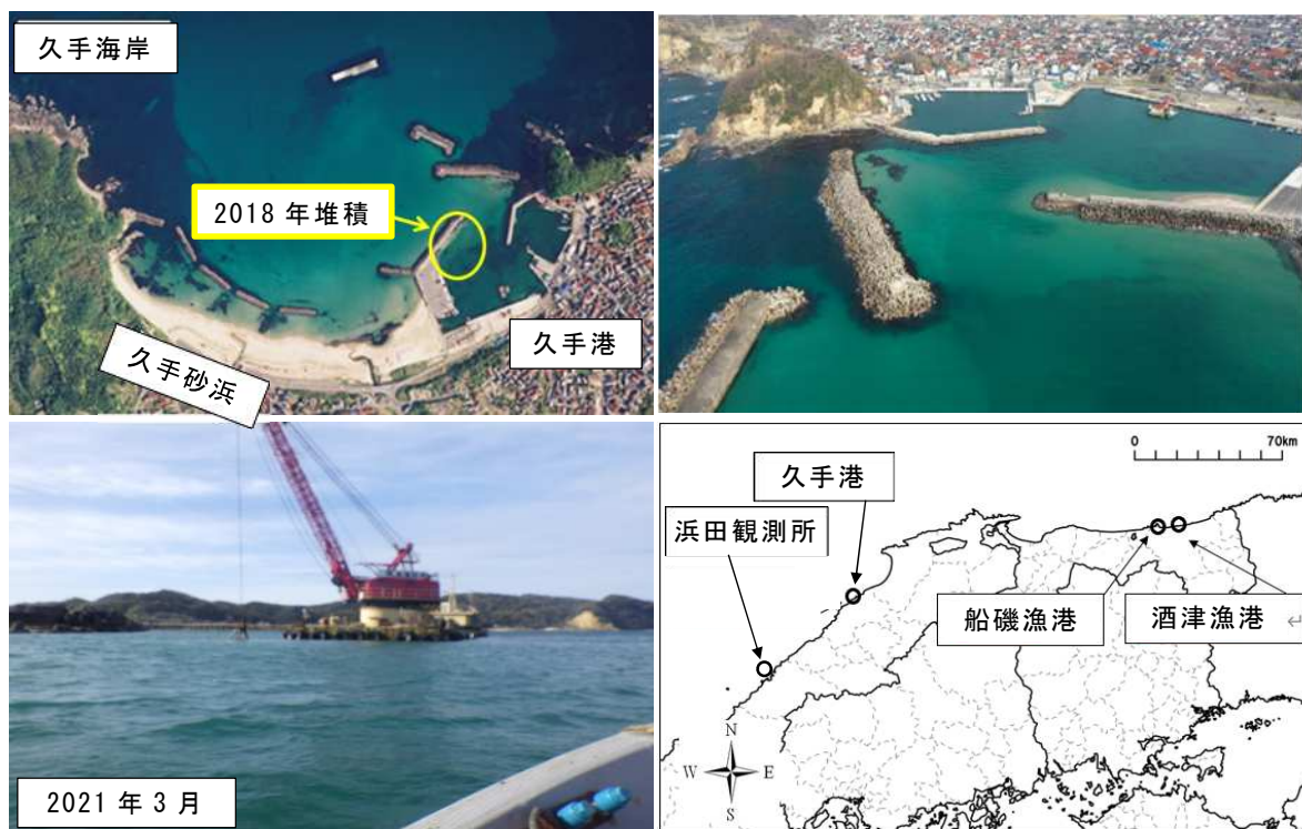
图 4.1 久手港概要と浚渫作業
